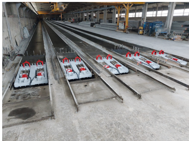
Nouvelles poutres réactives avec dispositif de relâchement des câbles
