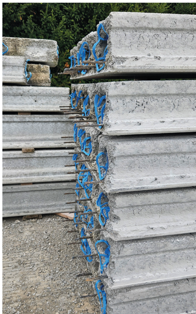
Dalles alvéolées avec fils de précontrainte apparents
