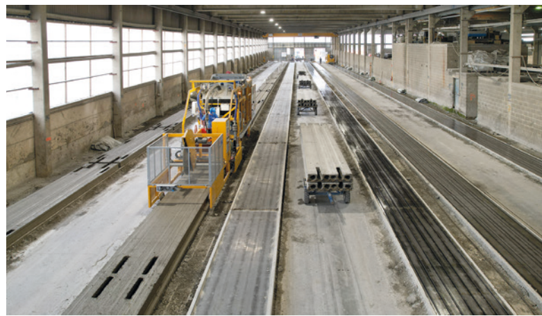
Vue intérieure de l'usine avec bancs de préfabrication
